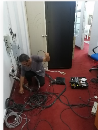
Kerja-kerja Rewiring CCTV
